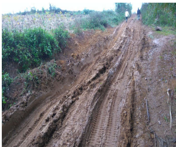
Đường VC gỗ không duy tu bảo dưỡng
